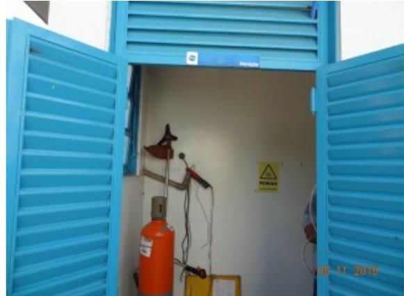
**Foto 4** - ETA/Pedro Ludovico com placa de aviso de risco na sala do clorador.
