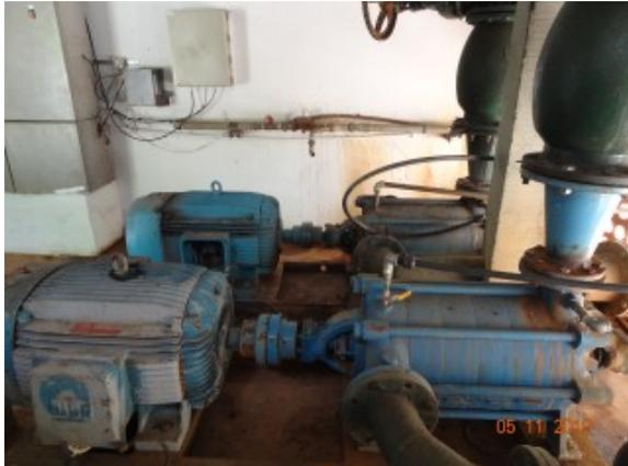
**Foto 3** - Eliminado vazamento na gaxeta da bomba da EEAB/Captação Pedro Ludovico.
