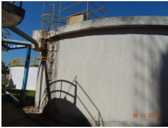
Foto 1 - Guarda-corpo na escada de acesso RSE da ETA.
