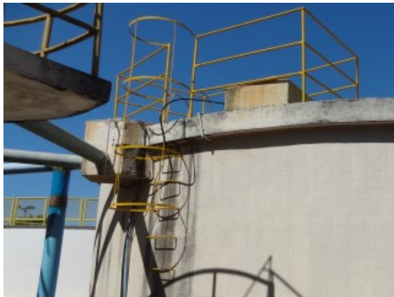
Foto 3 - Detalhe do guarda-corpo no topo do RSE da ETA.
