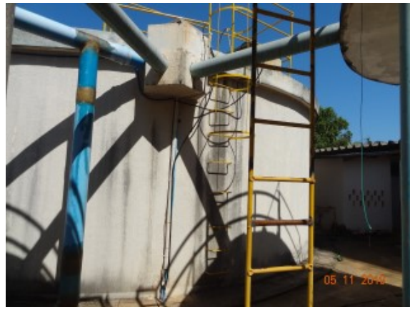
Foto 2 - Guarda-corpo na escada de acesso RSE da ETA.
