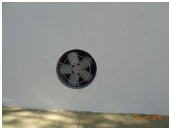
Foto 8 - Exaustor recuperado - sala de cloração.
