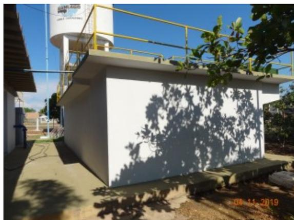
**Foto 5** - ETA com pintura externa recuperada.
