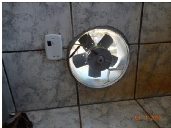
Foto 7 - Exaustor recuperado - sala de cloração.
