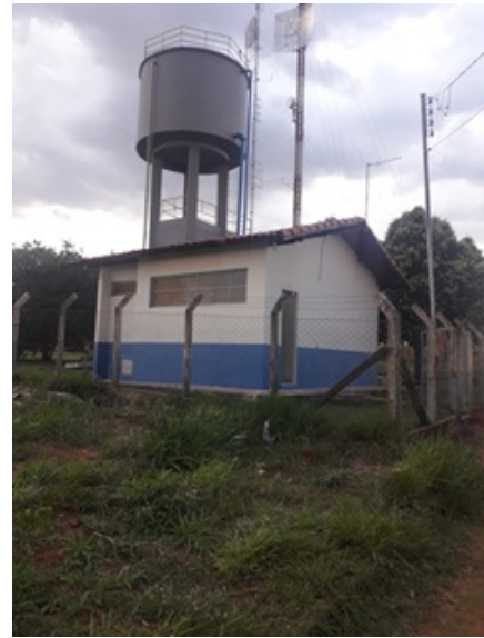
Foto 2 - ETA reformada parte externa.
