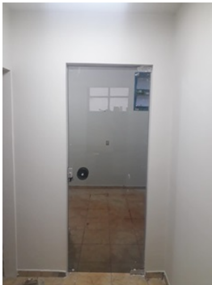
Foto 3 - ETA reformada parte interna.
