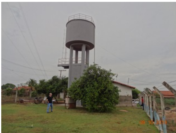
Foto 5 - REL da ETA com pintura recuperada.
