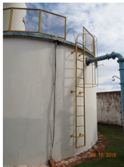
Foto 4 - RAP RII com guarda-corpos no topo e escada.
