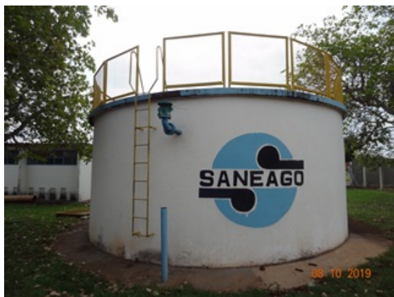
Foto 1 - RAP RI com guarda-corpos no topo.
