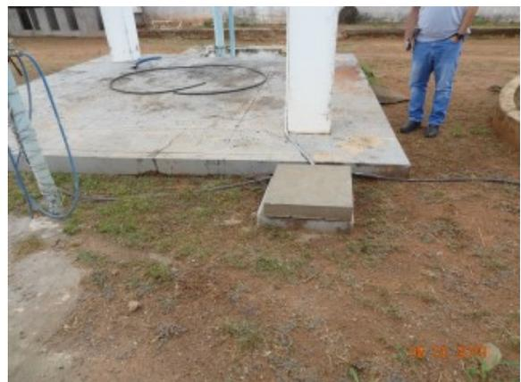
**Foto 6** - Caixas de passagem com tampas de proteção - EEAT.
