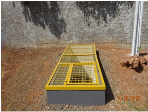
Foto 3 - Caixas de passagem com tampas de proteção recuperadas.
