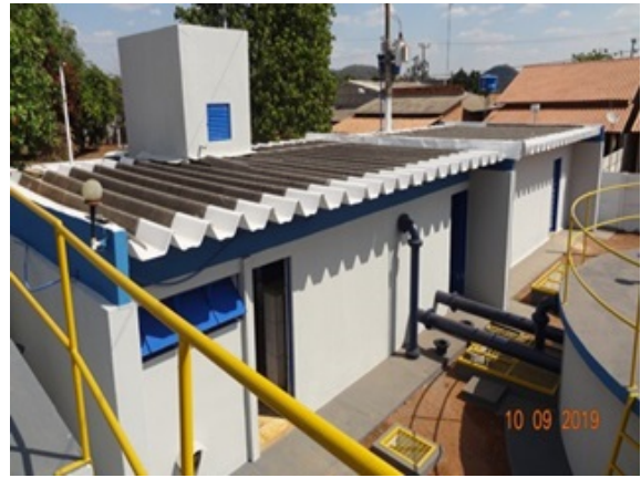
Foto 4 - Edificações da ETA com pinturas recuperadas.
