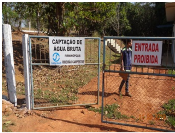
Foto 1 -Cerca de proteção da captação recuperada.
