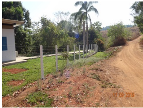
Foto 2 - Cerca de proteção da captação recuperada.
