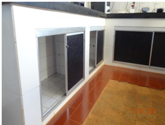
Foto 3 - Armários do laboratório da ETA recuperados.
