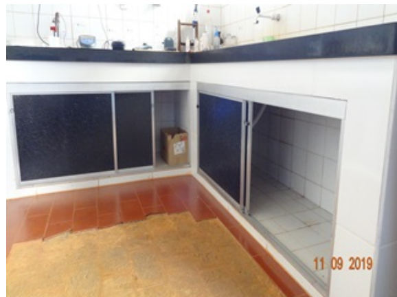
Foto 4 - Armários do laboratório da ETA recuperados.
