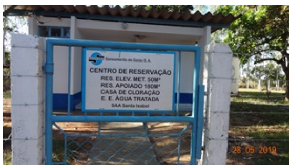
Foto 6 - ETA com placa de identificação recuperada.
