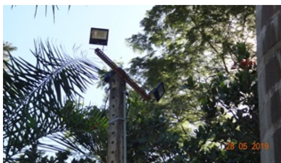
Foto 6 - EEE III com sistema de iluminação recuperado.
