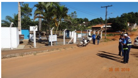
Foto 1 - EEE I com pintura recuperada.
