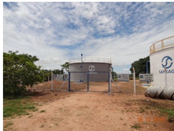
Foto 8 - Reservatório do C.R. setor Ponte de Pedra com constatações corrigidas.
