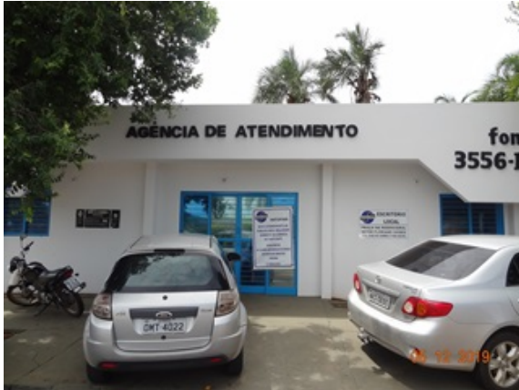
Foto 1 - Edificação do Escritório Comercial recuperadas.
