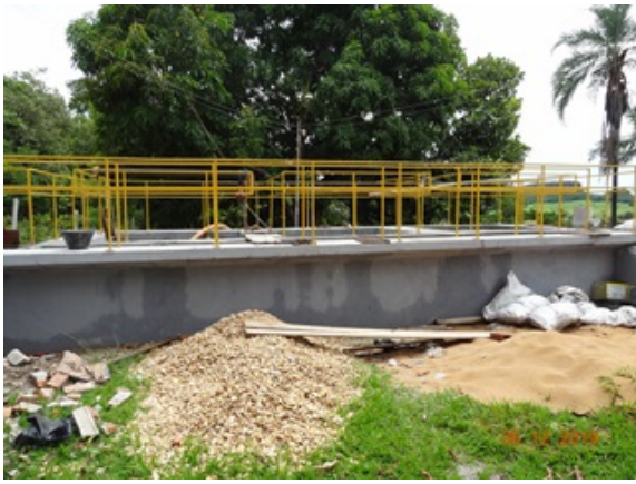
Foto 5 - ETA, poço de sucção com pintura e revestimento recuperado.
