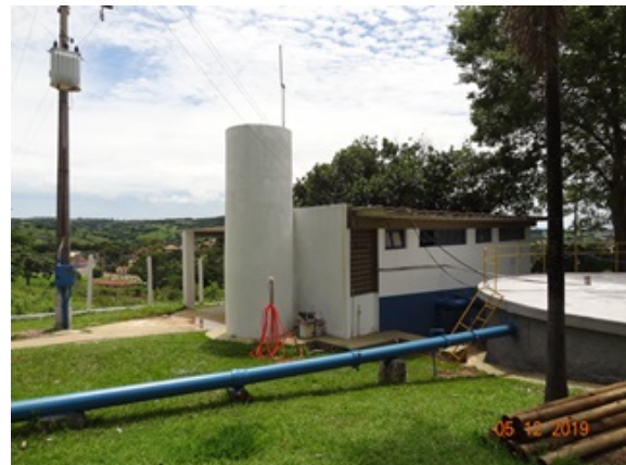
Foto 4 - ETA, com edificações físicas recuperadas.
