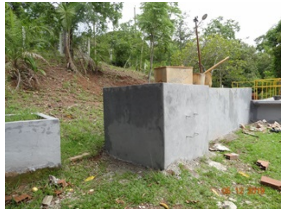
Foto 6 - ETA, poço de contato com pintura e revestimento recuperado.
