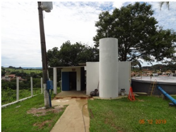
Foto 3 - ETA, com edificações físicas recuperadas.
