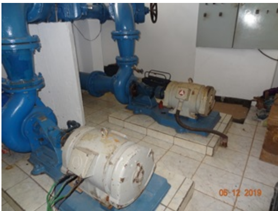
Foto 7 - EEAT/ETA, conjunto moto-bomba com vazamento na gaxeta corrigido.
