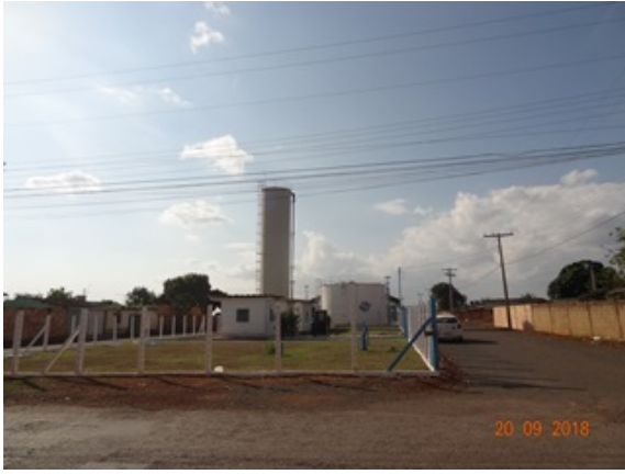
Foto 5 - Sistema de poços
