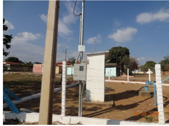
Foto 6 - Sistema de poços
