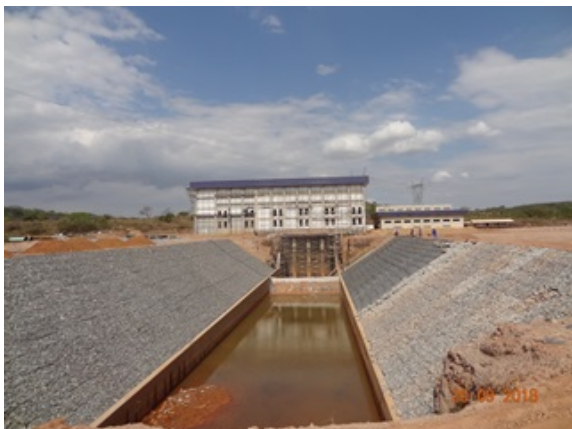
Foto 1 - Canal de entrada da nova captação
