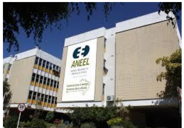
Energia Elétrica - Convênio com a ANEEL
