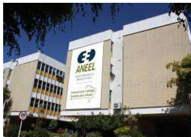
Energia Elétrica - Convênio com a ANEEL
