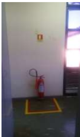
Figura 24 – SE Marajoara – Sala de Controle
