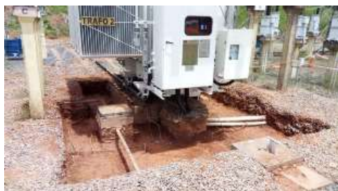
Figura 30 – SE CBR-S bacia em construção
