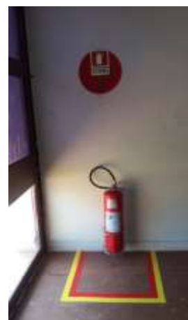
Figura 21 – SE Campinas – Sala de Comando
