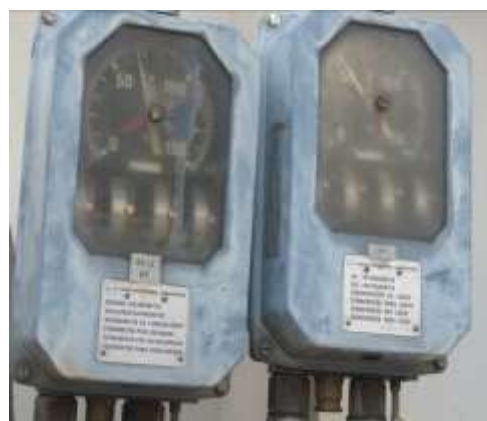
Foto 37.2 – Medidor de temperatura – ATL – TD 0080
