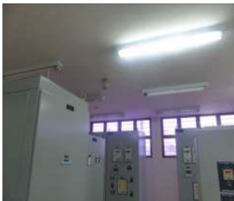
Foto 39.9 - Ausência/deficiência de iluminação – IND-S
