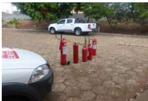
Foto 31.3 – troca de extintores (21/09/2018) – ATL-S
