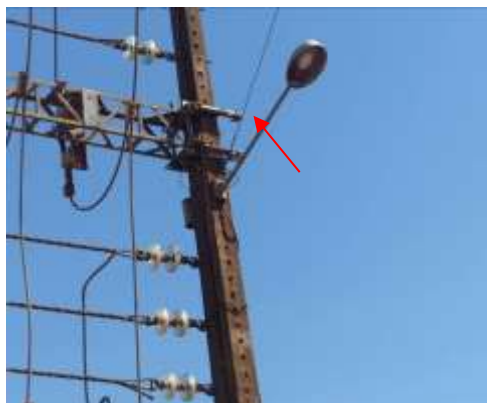
Foto 48.1 – Conexão do neutro do ramal externo – CRS-D
