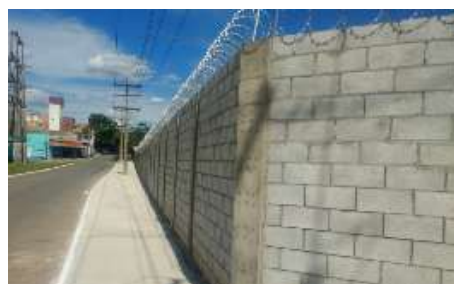
Figura 17.b – SE FER adequação do muro
