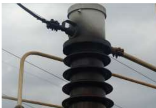
Foto 34.8 - vazamento e/ou merejamento – CAT-S –TC 138KV
