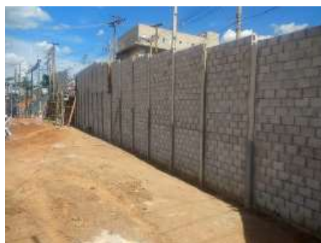
Figura 16.b – SE FER adequação do muro
