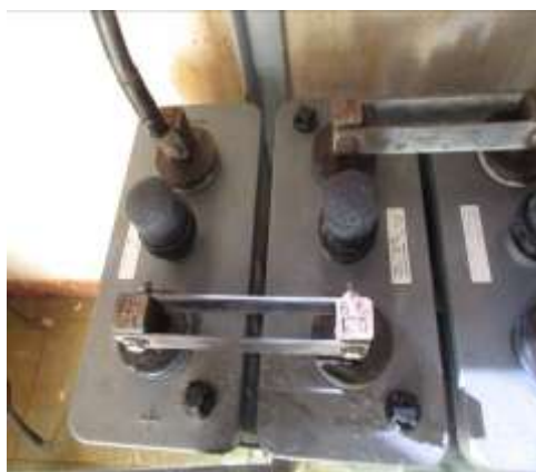
Foto 40.6 – Bateria com formação de líquido – RVE-S
