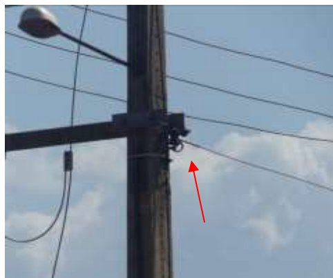
Foto 48.2 – Conexão do neutro do ramal externo – SE Palmelo
