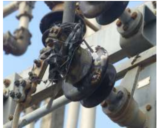
Foto 42.2 – sujeira – chave seccionador –ATL-S
