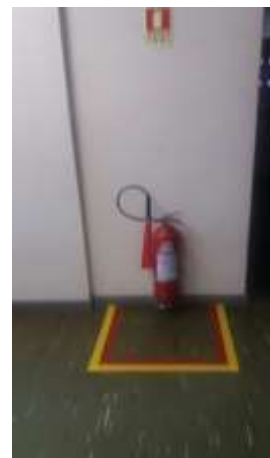
Figura 25 – SE Marajoara – Sala de Controle
