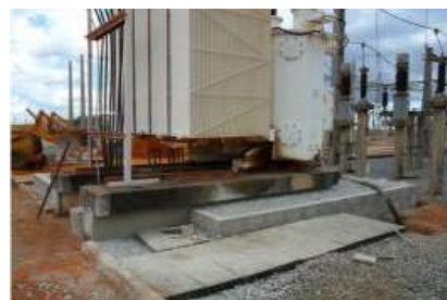
Figura 31 – SE ALD-S bacia em construída
