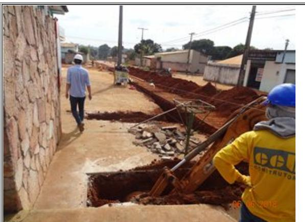
**Foto 2** - Construção de rede coletora de esgoto -
