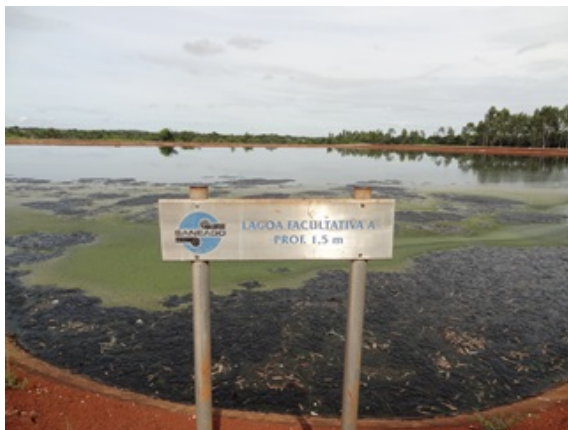
Foto 1 - ETE/Lagoa Facultativa (A) com taludes (bordas) desprotegidas e com início de erosão.
