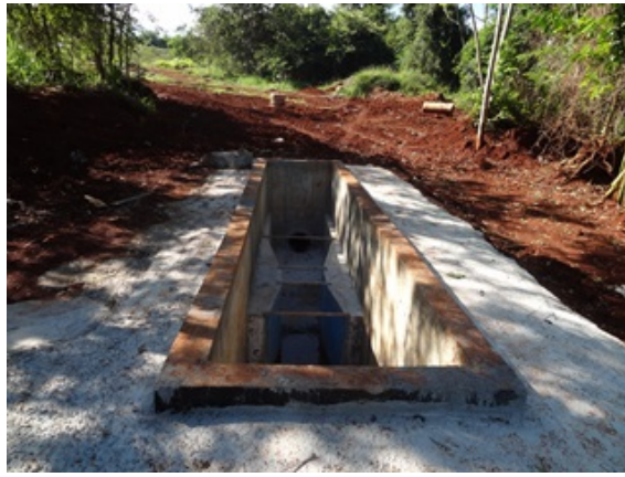
Foto 2 - Obras de mudança do ponto de lançamento de efluente.
