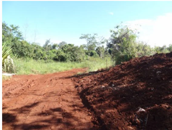
Foto 4 - Obras de adutora de efluente para novo ponto de lançamento no corpo receptor Rio Claro.
