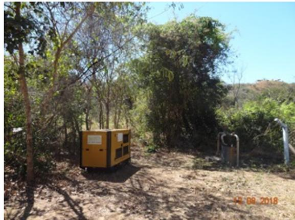
**Foto 4** - Instalação de grupo gerador no poço PGD 256, para bombeamento provisório no período de estiagem.
