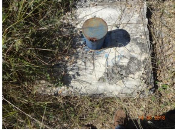
**Foto 2** - Poço PGD 180, a ser interligado ao SAA.
