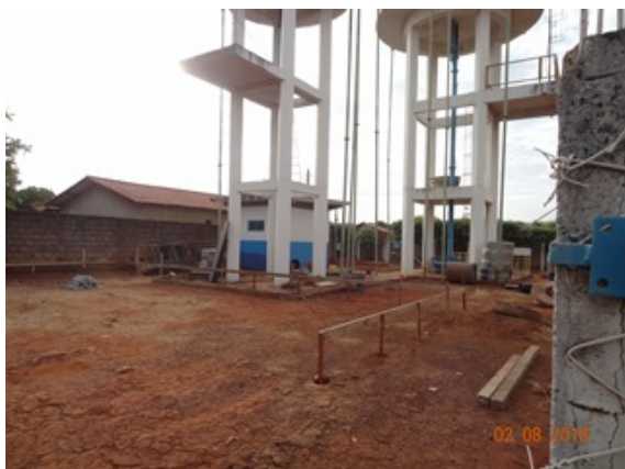
Foto 1 - Setor Aeroporto - base do futuro RAP de 500 m 3 em implantação.
