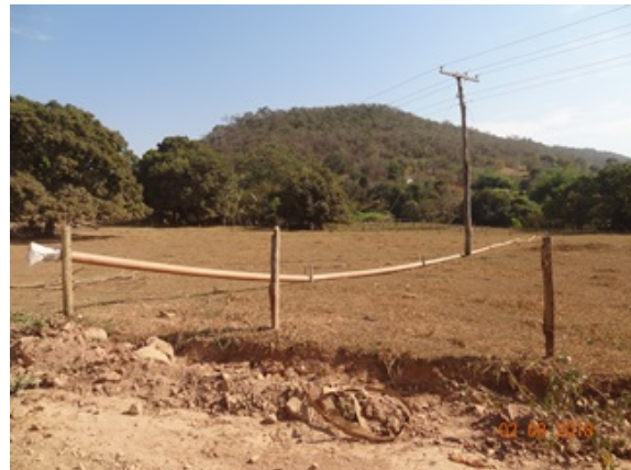
Foto 6 - Adutora provisória da captação do Córrego Empedrado.
