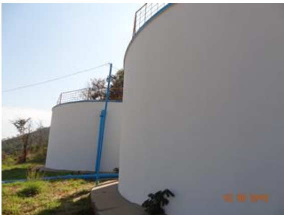
Foto 7 - Reservatórios RI e RII da Serra com pinturas refeitas.
