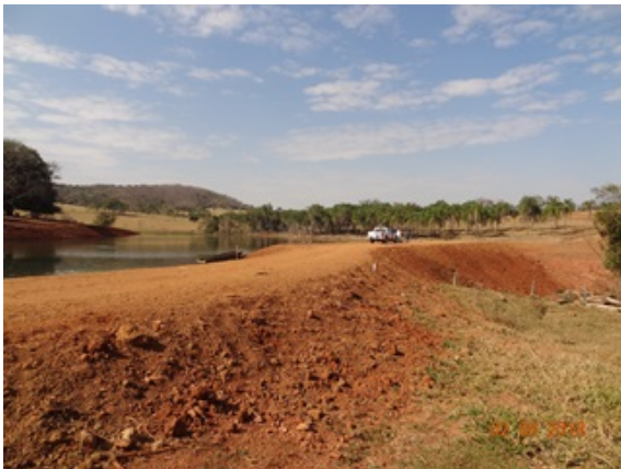
Foto 5 - Captação do Córrego Empedrado com barragem concluída.
