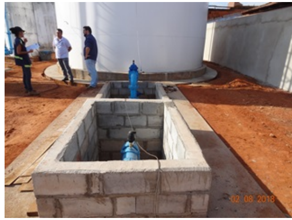
Foto 4 - São José: reservatório com obra já concluída e em uso.
