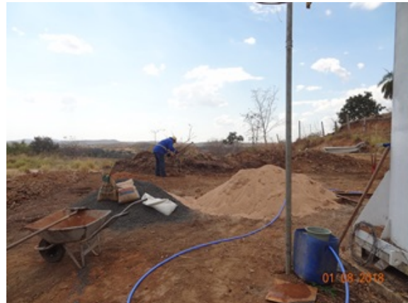
Foto 4 - REL de 50 m 3 em obras de revitalização da urbanização.
