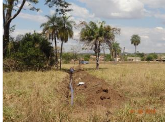
Foto 2 - Obras de interligação do Poço 418.
