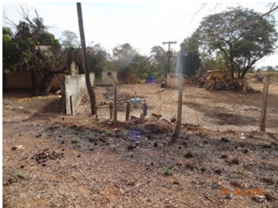
Foto 5 - Poço 307 com ausência de urbanização.
