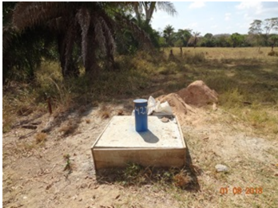
Foto 3 - Poço 429 em obras de interligação.
