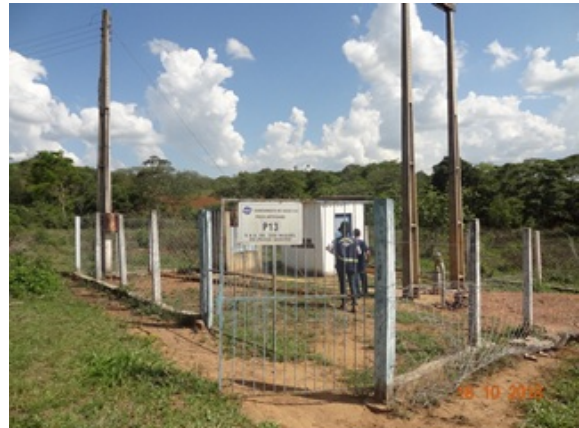
Foto 6 - Poço P 13 com cerca danificada.
