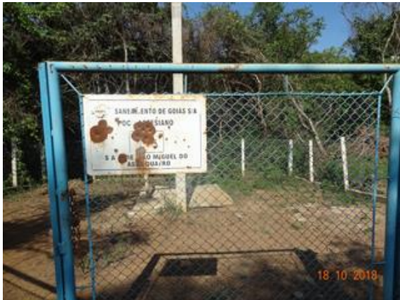
Foto 5 - Placa danificada e ilegível no Poço P 4.
