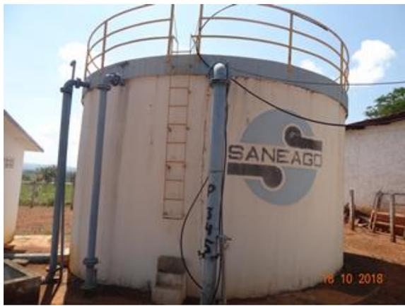
**Foto 3** - RAP com ausência de guarda-corpo na escada de acesso ao reservatório.
