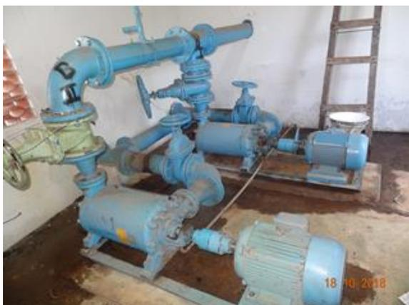
**Foto 1** - EEAB com presença de vazamento no conjunto moto-bomba.
