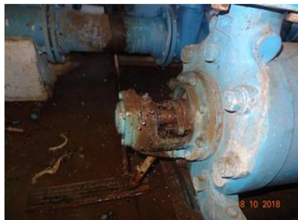
**Foto 2** - Vazamento no conjunto moto-bomba.
