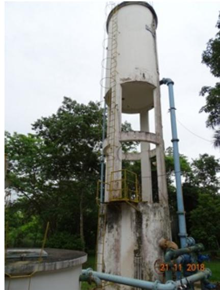
**Foto 4** - REL/ETA - ausência de guarda-corpo.
