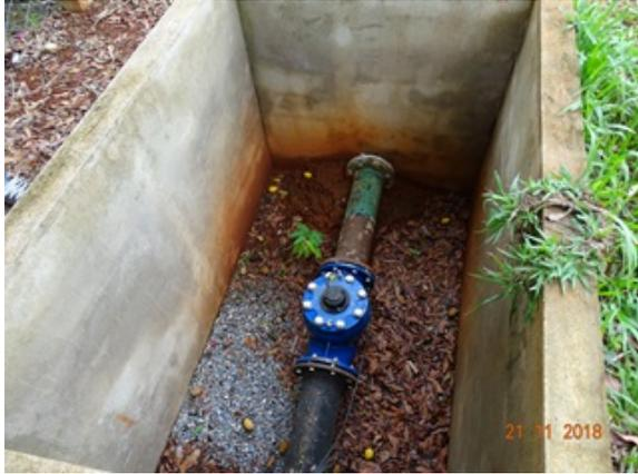
**Foto 3** - Caixa de passagem sem tampa ou grade de proteção.
