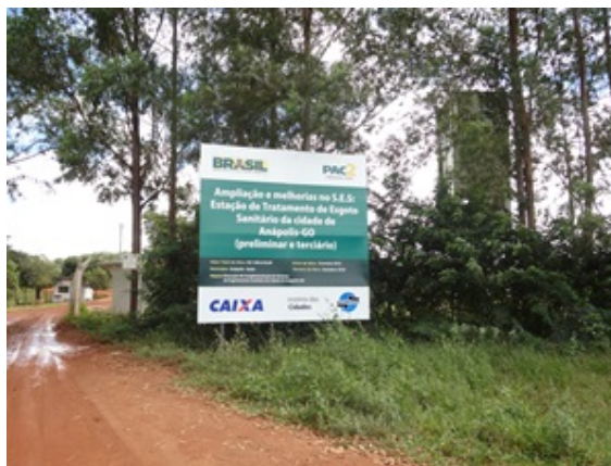
Foto 2 - ETE com placa de aviso de risco apagada.
