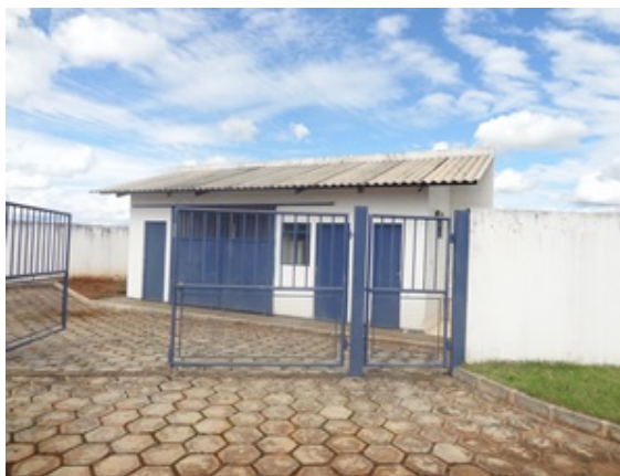
Foto 4 - EEE Terras Alphaville sem placa de aviso de risco.
