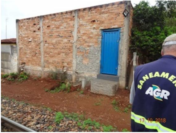
**Foto 5** - EEE do presídio com ausência de revestimento e pintura.
