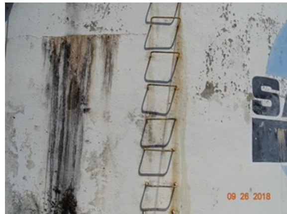
Foto 4 - Ausência de guarda-corpos.
