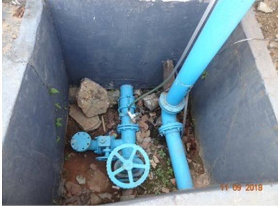
**Foto 3** - Caixas de passagem sem proteção.
