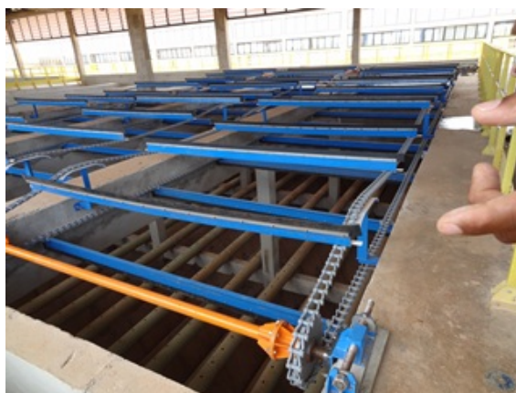
Foto 7 - ETA - Montagem dos equipamentos
