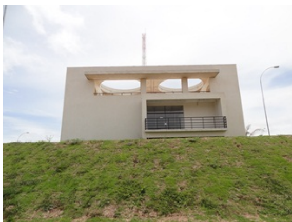
Foto 5 - ETA - Prédio da administração e Laboratório
