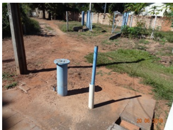
Foto 1 - Área do distrito com cerca de proteção e portão aberto.
