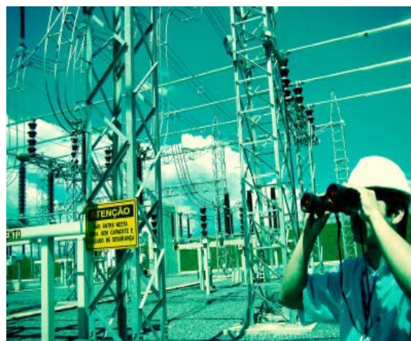
Energia Elétrica - Convênio com a ANEEL
