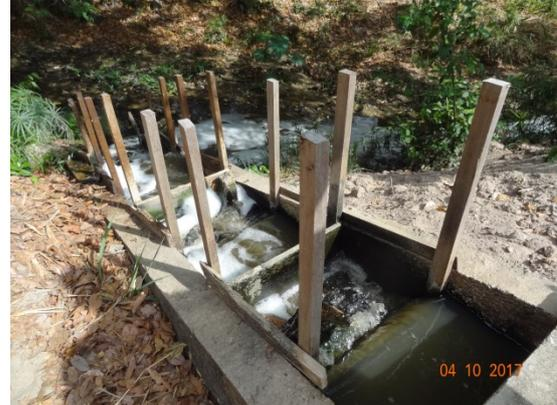
**Foto 10** – ETE com escada de redução de velocidade de água em construção.
