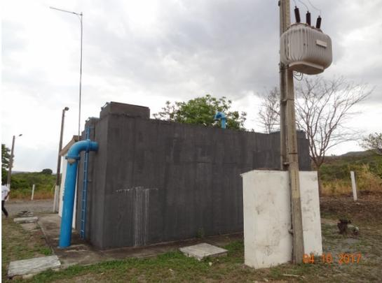
**Foto 9** – RAP Chácara Pecuária com ausência de guarda-corpos na escada e no topo.
