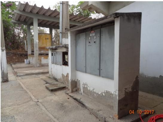
**Foto 3** – ETA com e pintura da danificada e perda de revestimento no quadro de comando.
