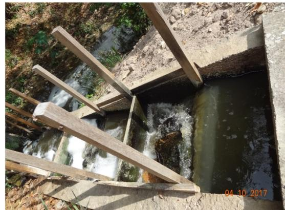
**Foto 14** – ETE escada de redução de velocidade de água.
