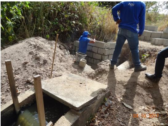
**Foto 31** – ETE PV padrão Saneago em construção junto à escada de redução de velocidade de água.
