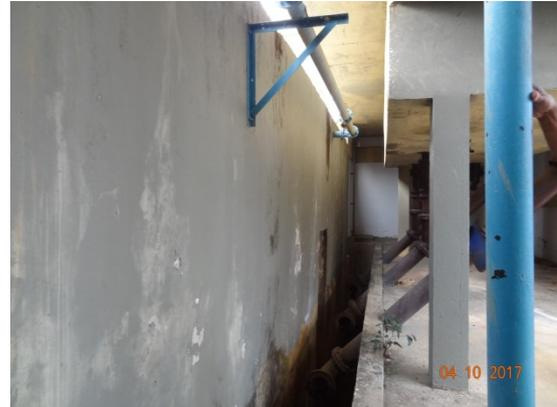
**Foto 2** – ETA com pintura danificada na galeria de filtros.
