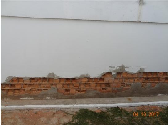
**Foto 1** – ETA com perda de revestimento na parede externa da sala de abrandamento.
