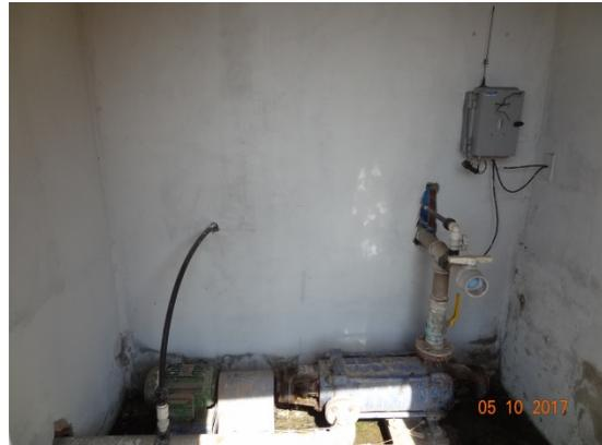
**Foto 6** – EEAT/Booster Aeroporto com vazamento na bomba.
