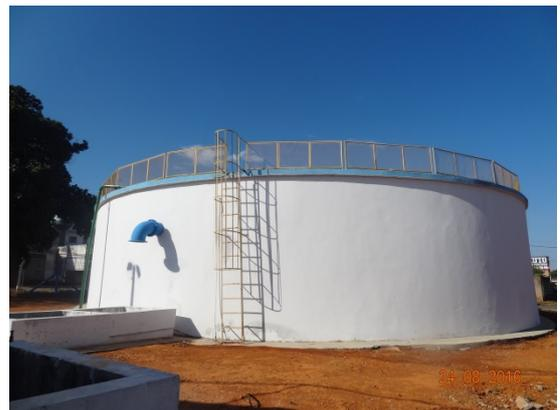
**Foto 12** – RAP CR Cruzeiro do Sul com infiltração eliminada.
