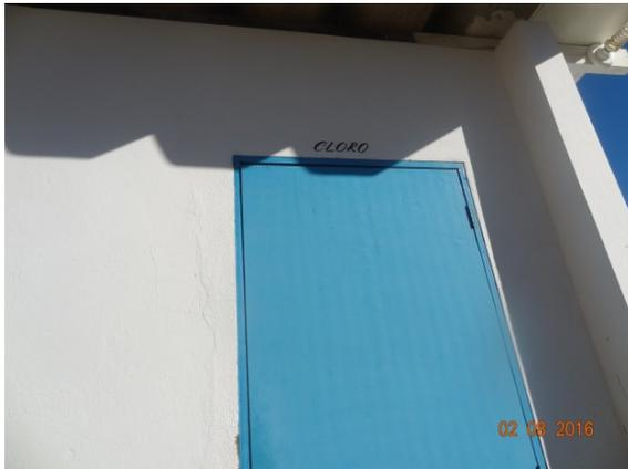
**Foto 1** – Sala do clorador sem aviso de risco
