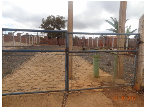
Foto 4 –Poço Setor Bela Vista sem identificação
