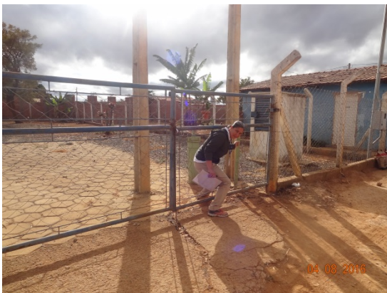
Foto 5 –Poço Setor Bela Vista com cerca danificada
