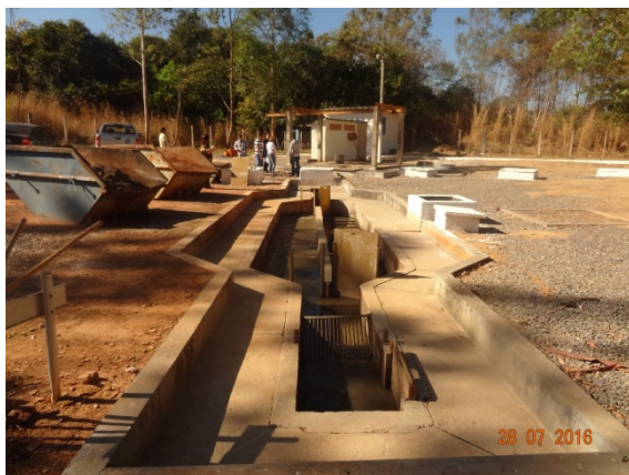
Foto 3 – Grades de retenção de detritos, caixa de areia e pátio limpos
