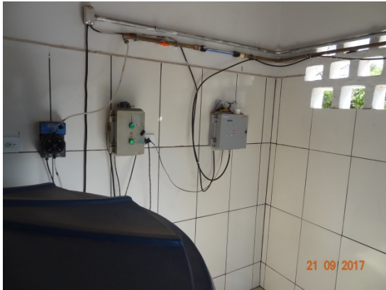
Foto 3 – Casa de cloração com revestimento recuperado.
