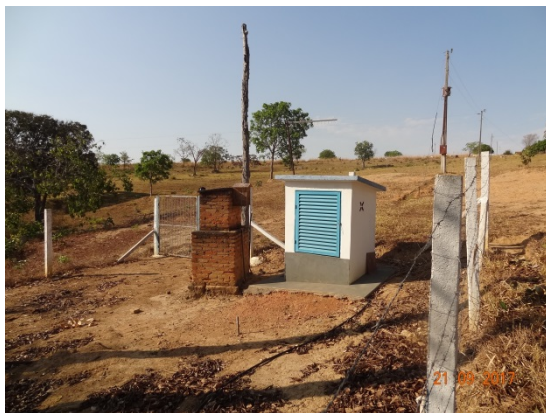
Foto 1 – Abrigo do quadro de comando reconstruído
