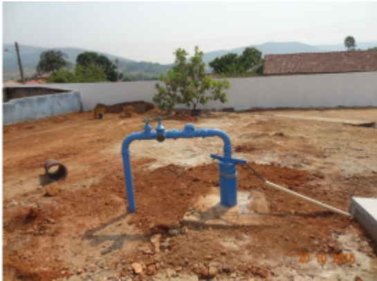
Foto 4 - Poço usina de areia
