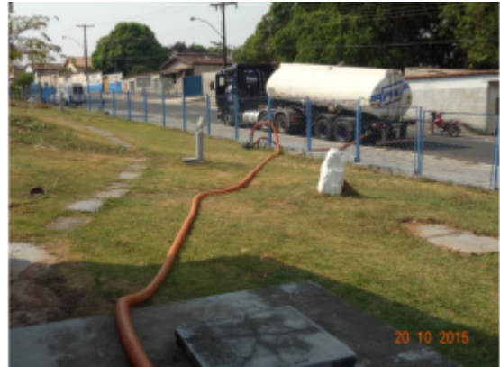
Foto 5 - Entrega de água por caminhão pipa
