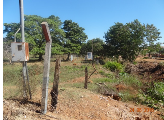
Foto 2 – Poço P14 com difícil acesso
