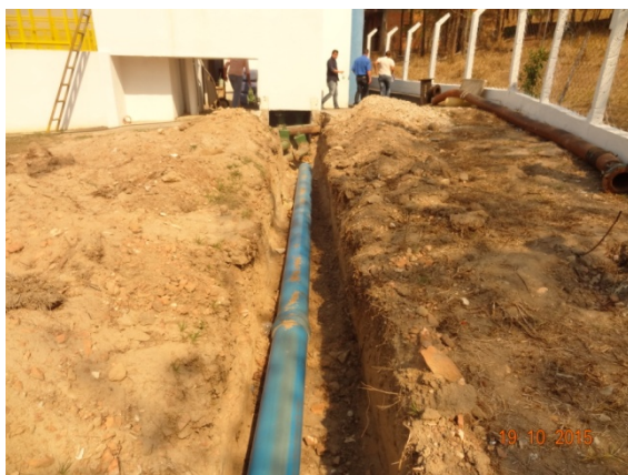
Foto 1 – Nova adutora de água bruto
