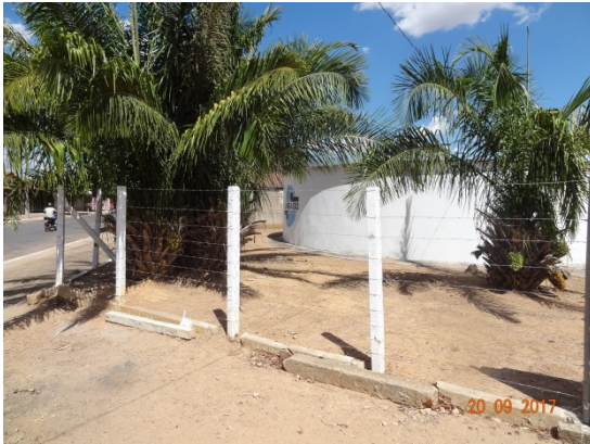
Foto 5 – RAP da Vila Bandeirante com cerca de proteção recuperada.
