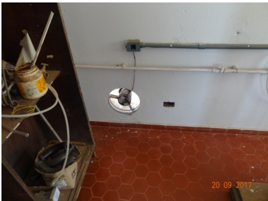
Foto 3 – ETA, sala do clorador com exaustor e revestimento recuperado.
