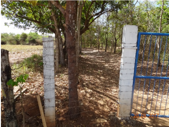
Foto 1 – Captação/ EEAB cerca de proteção recuperada.
