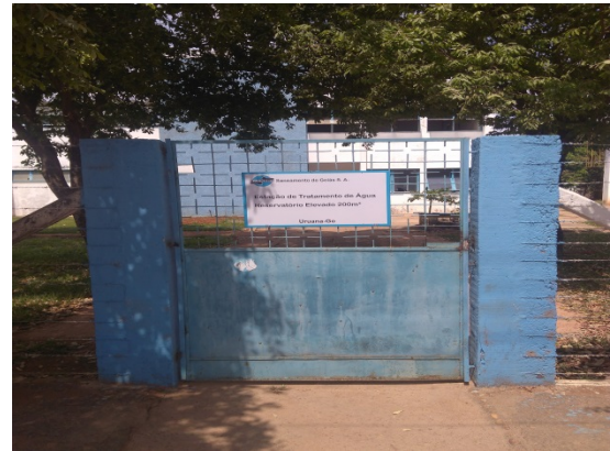
Foto 2 – Placa de identificação da ETA com pintura recuperada.
