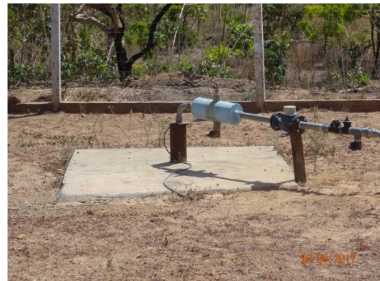
Foto 4 – Poço com laje de proteção recuperada.
