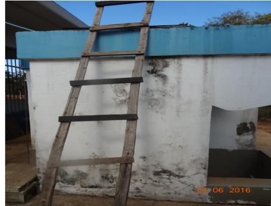
**Foto 6** – RAP tanque de contato com pintura desgastada
