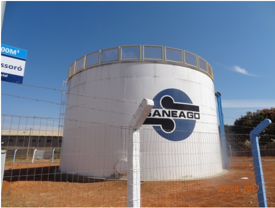
Foto 1 – RAP metálico 1000m 3 /Mossoró
