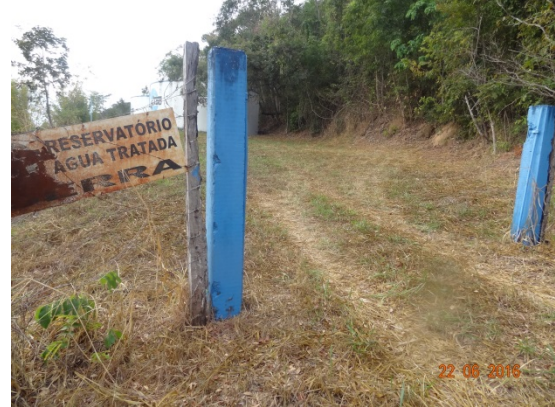
Foto 6 – Área dos R I e R II da Serra sem portão
