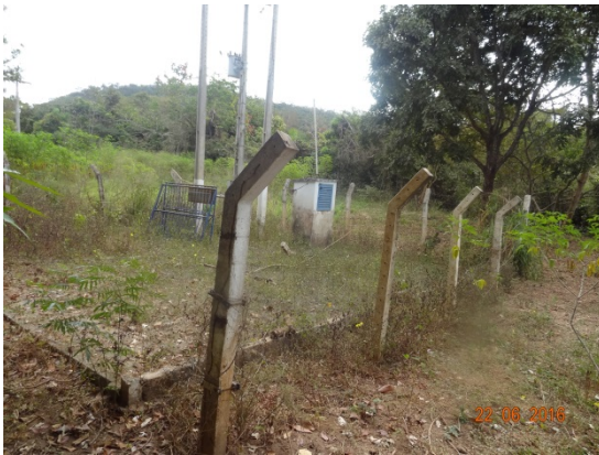
Foto 3 – Poço 5 Olina com mato alto e cerca danificada.
