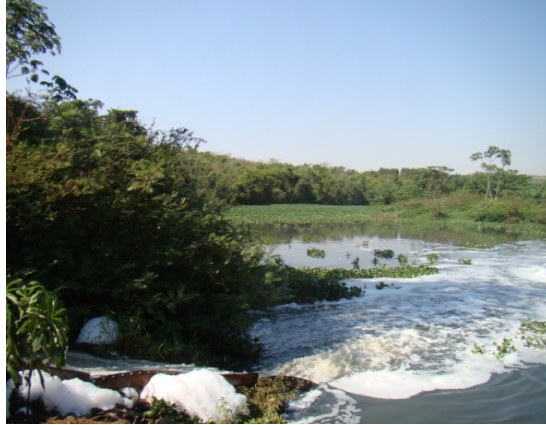
Foto 5 –Ponto de lançamento do efluente tratado
