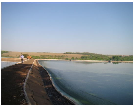
Foto 3 - Sistema tratamento ETE Jataí
