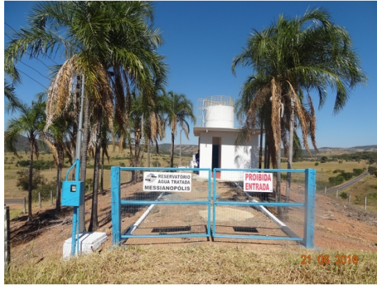
Foto 1 – REL com guarda-corpo instalado
