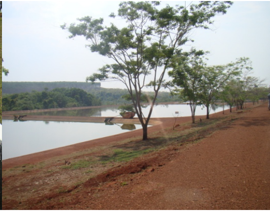
Foto 4 - Sistema lagoas ETE
