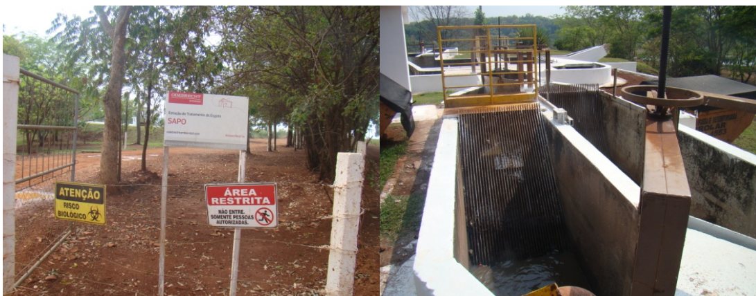
Foto 1 – Identificação da ETE Foto 2 - Entrada efluentes ETE
