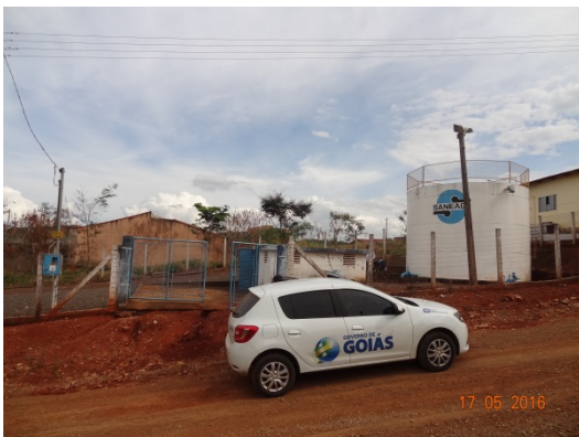
Foto 3 – Booster Jardim Tropical I com pintura desgastada
