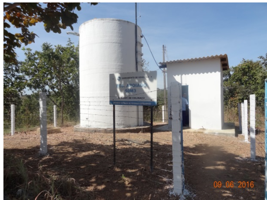
Foto 3 – Casa de cloração com pintura refeita
