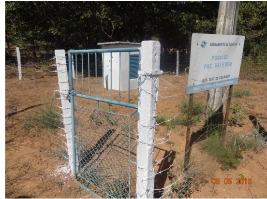
Foto 2 – Portão com cadeado no poço 2.
