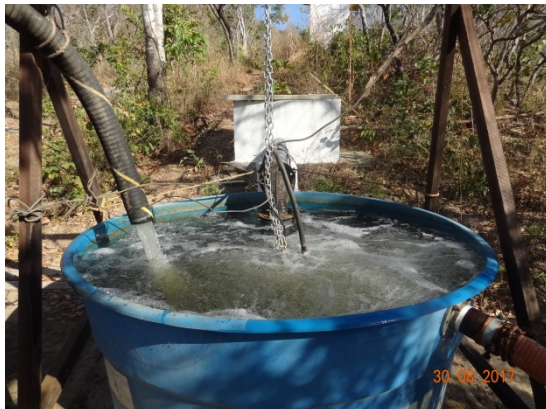
Foto 3 – Captação provisória do Rio Vermelho.
